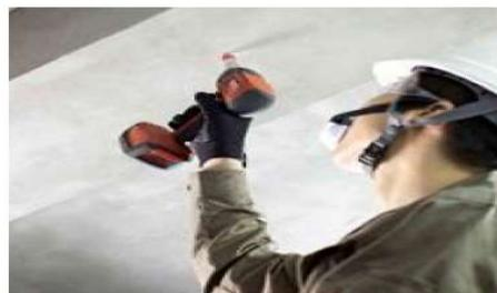
推奨のトルク性能\*を有するインパクトドライバーであれば使用可能！専用の工具は必要とせず、市販の14mmソケットでねじ込み可能！
