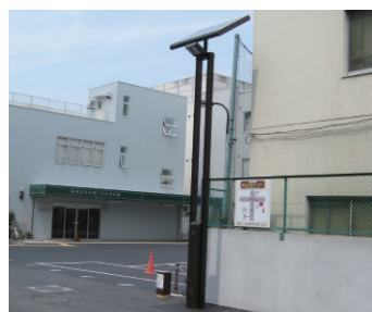
新宿区区役所照明灯
