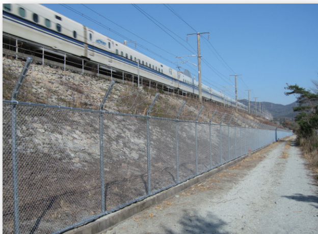
JR フェンス工事
