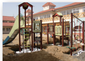
某幼稚園遊具基礎 (和歌山県)
