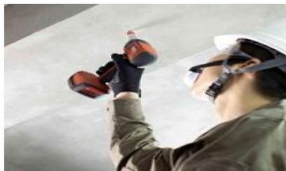
推奨のトルク性能\*を有するインパクトドライバーであれば使用可能！専用の工具は必要とせず、市販の14mmソケットでねじ込み可能！
